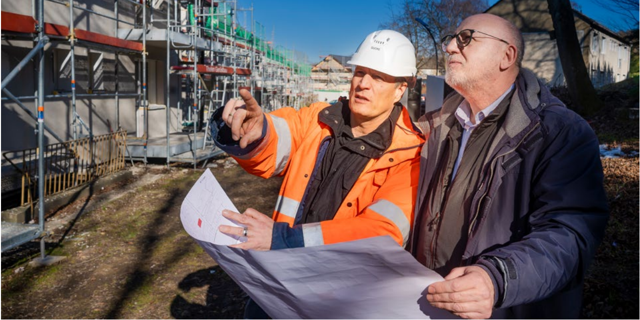
▲ Baustellenbegehung bei dem Sanierungsobjekt Langmannskamp.
