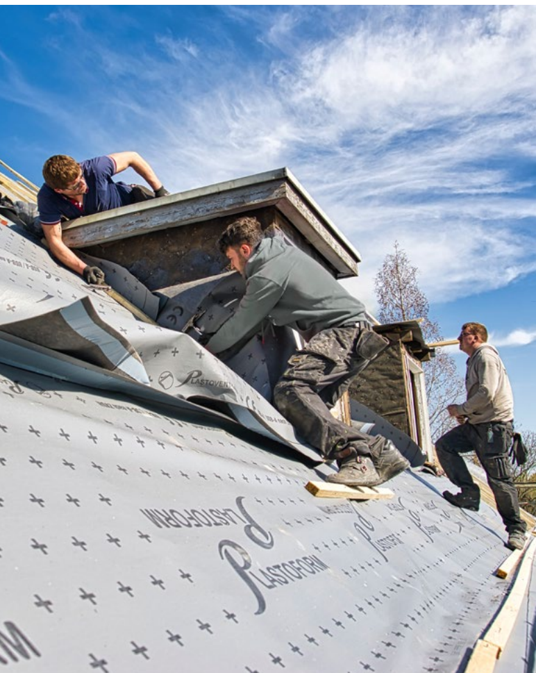
▲ Handwerker bei Dachmodernisierungsarbeiten.
